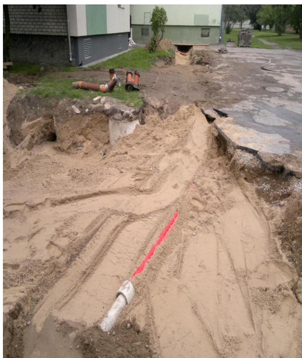
Siltumtīklu rekonstrukcija no Lidotāju ielas Nr.20 līdz Lidotāju ielai Nr.22, Saldus ielai Nr.3, Nr.1, Ventspilī
