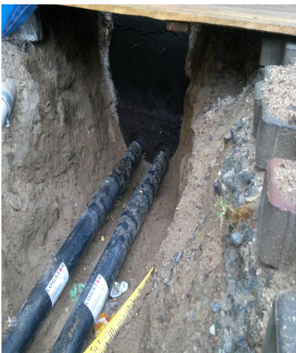
Siltumtīklu rekonstrukcija no Lidotāju ielas Nr.20 līdz Lidotāju ielai Nr.22, Saldus ielai Nr.3, Nr.1, Ventspilī
