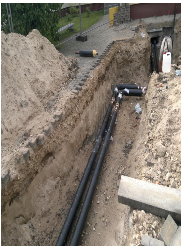
Siltumtīklu rekonstrukcija no Lidotāju ielas Nr.11 līdz Lidotāju ielai Nr.13, Ventspilī
